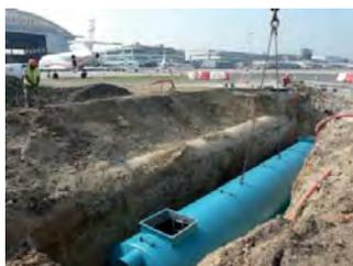
Pose de séparateurs d'hydrocarbures en zone réservée à l'Aéroport du Bourget (93)
